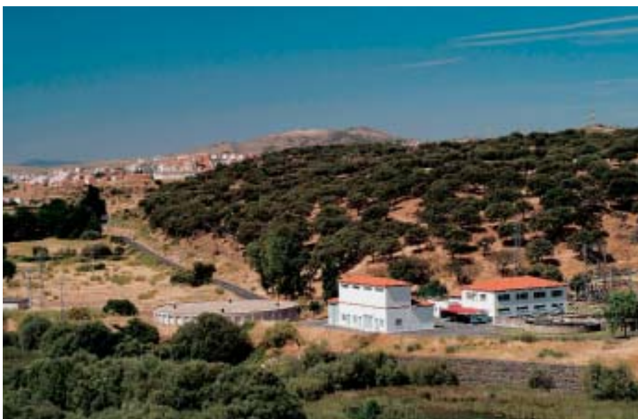
➤ Mejora en la infraestructura de abastecimiento de agua potable. Planta potabilizadora.
