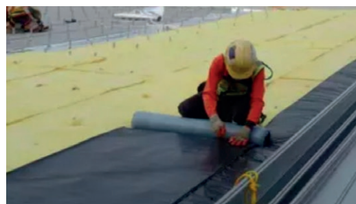
Figura 3 – Colocación de lámina bituminosa tipo TEXSEF GS 1,5 sobre forjado 18
