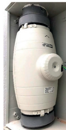
Figura 4 – Ejemplo sistema de extracción.
