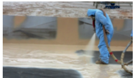
Figura 3 – Aplicación de sistema líquido tipo Urespray f-75 mediante proyección sobre forjado. /11
