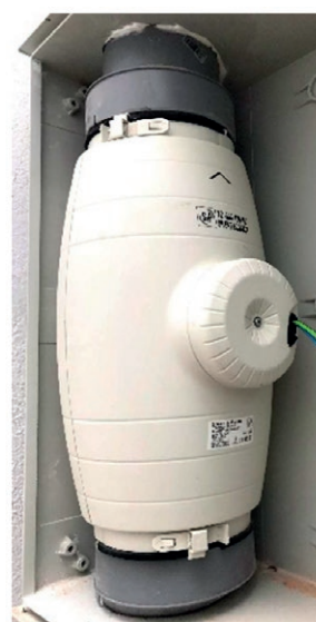
Figura 3 – Ejemplo sistema de extracción
