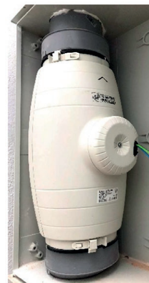
Figura 3 – Ejemplo sistema de extracción
