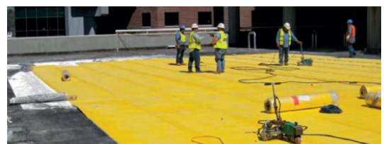
Figura 3 – Colocación de lámina PVC reforzada con poliéster tipo Coreflex XP sobre forjado. 9
