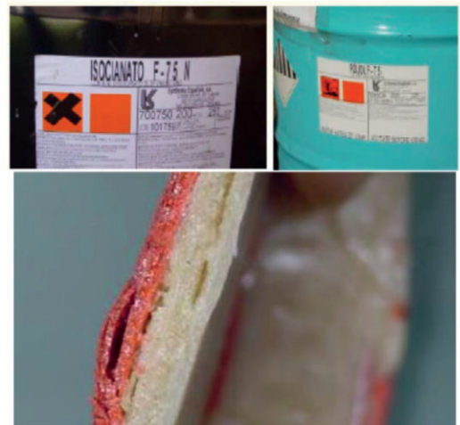
Figura 2 – Ejemplo de suministro y puesta en obra por proyección en varias capas de sistema líquido tipo Urespray F-75. /10
