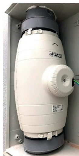
Figura 4 - Ejemplo sistema de extracción.
