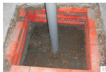
Figura 3 - Ejemplo de arqueta de impulsión ejecutada "in situ". / Fuente: Borja Frutos Vázquez
