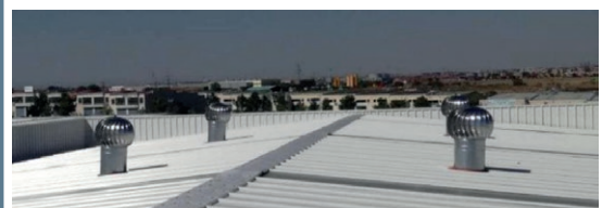
Figura 4 – Ejemplo de caperuza ventilación. /17
